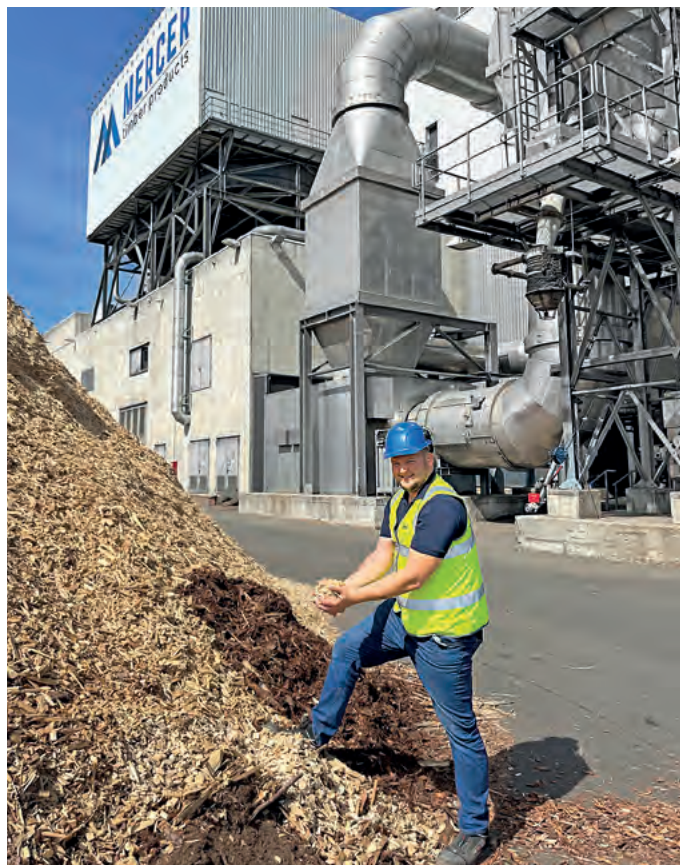
„Die Qualität muss stimmen“ , sagt Kraftwerksleiter Zimmermann. Der Output des Heizkraftwerks im Hintergrund liegt bei 50 MW therm und 12,9 MW elektr
